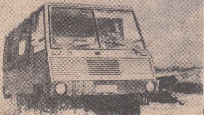
Грузопассажирский вездеход «Чавдар-5 СУ» (на снимке) создан болгарскими инженерами. 16 пассажиров располагаются на местах вдоль боковых бортов грузовой платформы. Машина может преодолевать подъемы в 32 градуса и броды глубиной до метра. Мощность двигателя 80 лошадиных сил.
